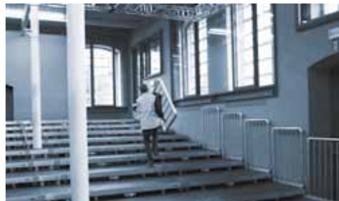
Vereinfachte Befestigung des Geländers durch Steckvorrichtung, dazu die Ausführung aus leichtem Aluminium, spart Zeit und Kraft!
