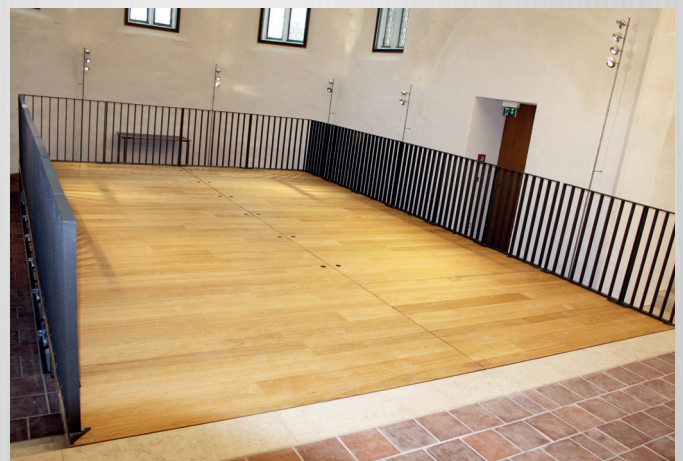
Eine Überbauung von Treppenanlagen in einer Kirche.
