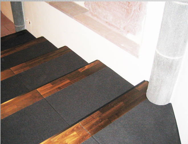
Bau einer Chortribüne unter Berücksichtigung der Säulen.
