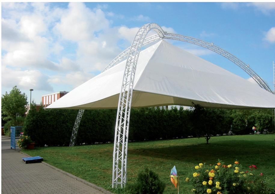
Pirámides BÜTEC, la cubierta flotante con solo tres soportes una construcción de aspecto muy ligero para eventos especiales. Diseño y modelo con protección de modelos registrados.
