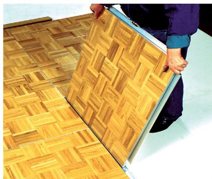
Así se continúa, hacia la derecha siempre con tableros enteros de modo que nunca se forme una unión en cruz. Solo al final, en cada segunda fila se vuelve a colocar medio tablero. Esta forma de colocación permite que las filas se sujeten unas a otras y que nunca se encuentren cuatro esquinas, lo que impide un desplazamiento de la superficie.
