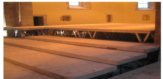
**Tarimas comprobadas para cargas de hasta 750 kg/m<sup>2</sup>**
