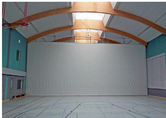
Cortina de separación instalada en una viga maestra de madera encolada
