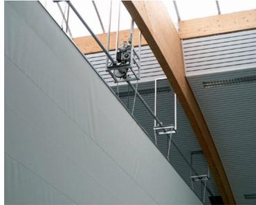
**Eje continuo:** con rodamiento de bolas sin mantenimiento fijado cada 3,5 - 4,0 m a soportes de cojinetes. Las cintas para elevar el tubo de elevación se enrollan en el eje con horquillas para cintas.
