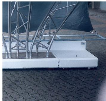
Contrapeso mediante instalación en piezas elaboradas de cemento
